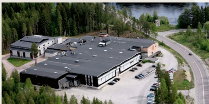
Unimedics anläggning i Matfors.
